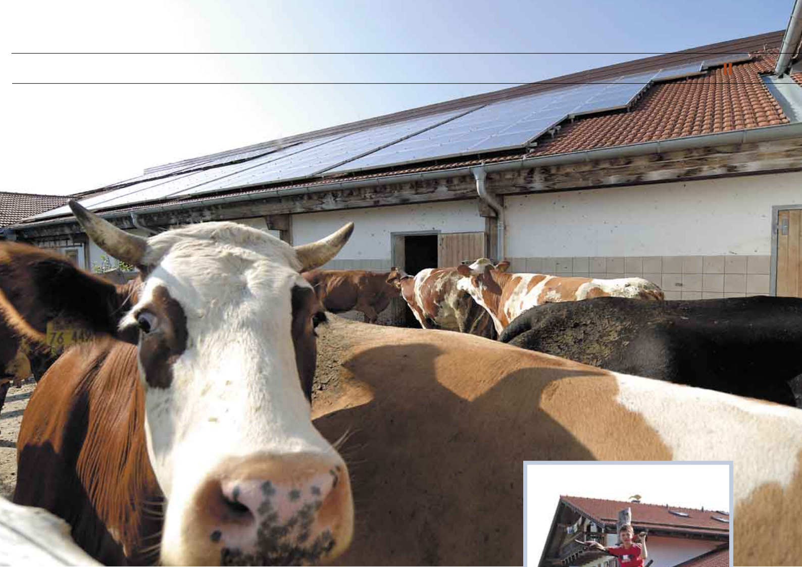
Zwei der drei Solarstromanlagen haben auf dem Kuhstall Platz gefunden.
